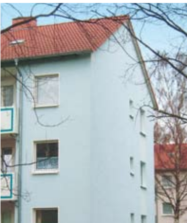
Mit WDVS sanierte Fassade
